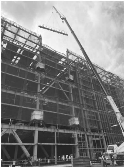
「吊り上げの儀」の様子
