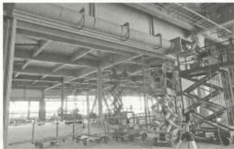
設置中の防火シャッター。天井高は5・5m、床荷重1・5tを確保
