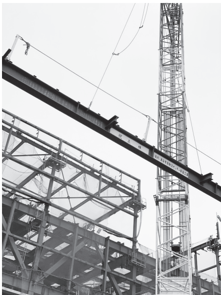
最後の鉄骨梁を吊り上げた
