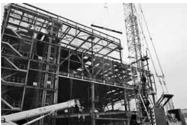
吊り上げられた最後の鉄骨
